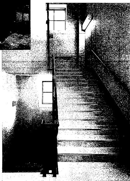
3階 昇降口アプローチ
